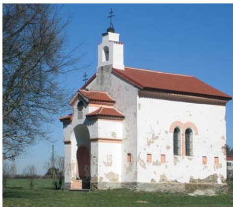
Zdiměřická kaple s novou taškovou střechou.
