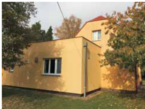
Přístavba kuchyně z roku 2003
