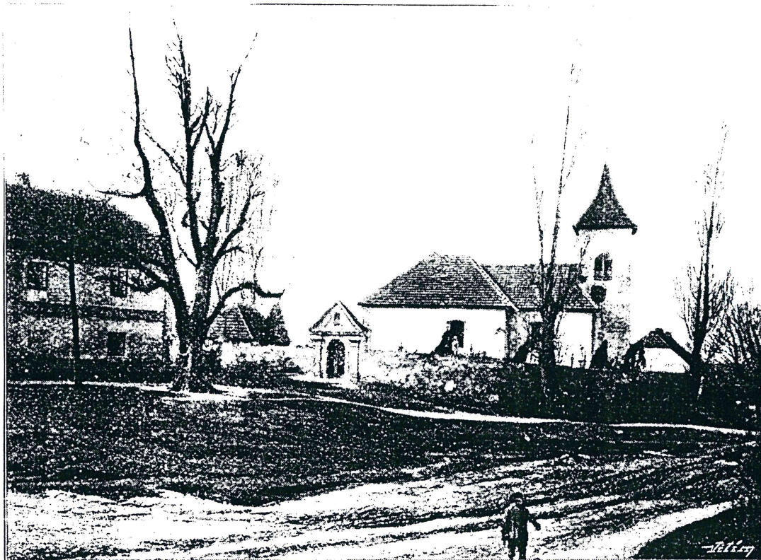
Celkový pohled na hrnčířský kostel sv. Prokopa podle fotografie, vzniklé před rokem 1898
