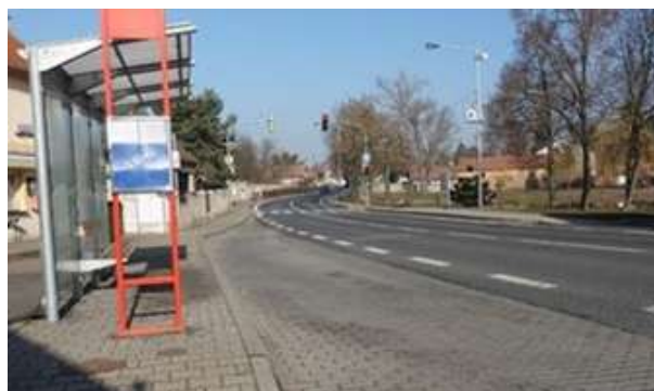
Obrázek 126 – Ukázka absence VDZ V 11a v místě autobusové zastávky „V Ladech“.
