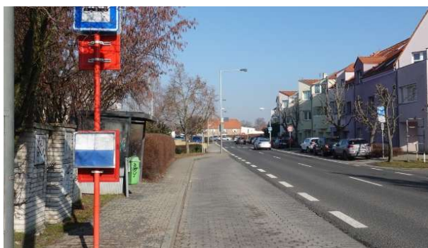
Obrázek 132 – Chybné oddělení zálivu od jízdního pruhu v zastávce „Pod Vší“ ve směru sever \Rightarrow jih.
