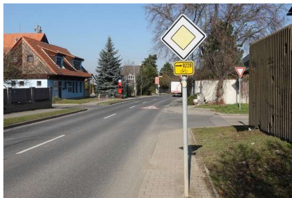
Obrázek 165 – Absence VDZ V 2b a V 4 v místě křižovatky MK K Šeberovu a Zadní.
