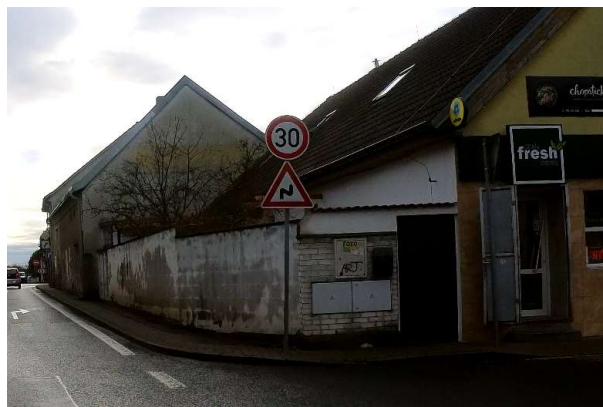
Obrázek 155 – Nevhodná posloupnost SDZ B 20a a A 2a v MK K Hrnčířům.
