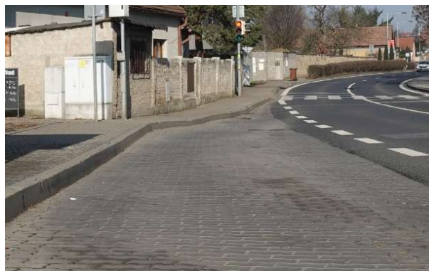
Obrázek 173 – Další ukázka propadu povrchu v místě autobusového zálivu.
