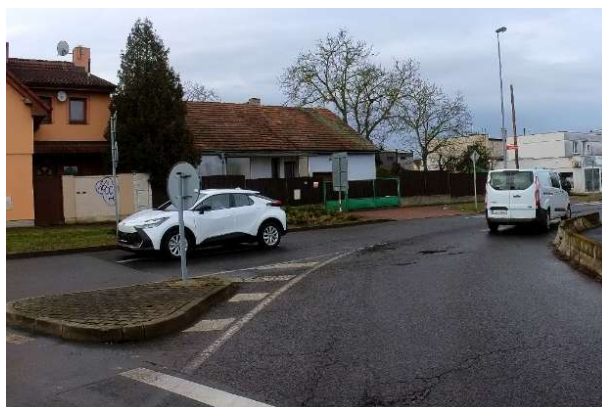
Obrázek 139 – Opotřebované VDZ V 13 v MK K Labeškám.
