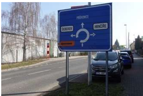
Obrázek 160 – Pohled na SDZ IS 9b na nedeformovatelné konstrukci v místě západního ramene MK K Labeškám.
