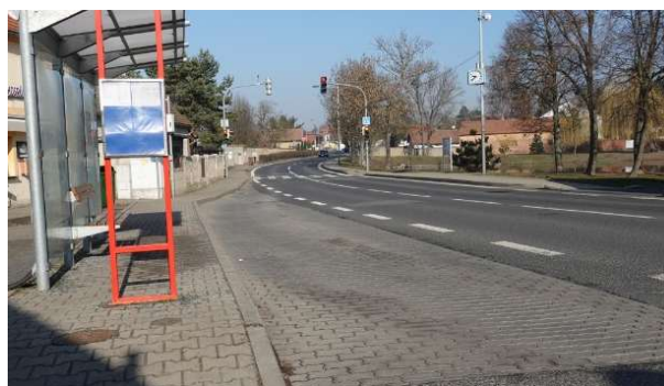
Obrázek 131 – Chybné oddělení zálivu od jízdního pruhu v zastávce „V Ladech“.
