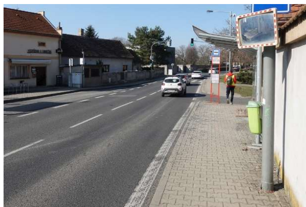
Obrázek 91 – Absence OOSPO prvků v místě zastávky „V Ladech“ v MK K Hrnčířům.
