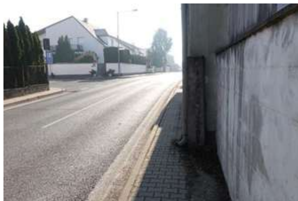
Obrázek 83 – Pohled na úzký chodník v blízkosti náměstí Šeberov poblíž směrového oblouku.
