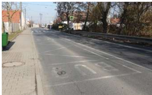
Obrázek 124 – Pohled na opotřebované VDZ V 11a v zastávce „Hrnčířský hřbitov“.
