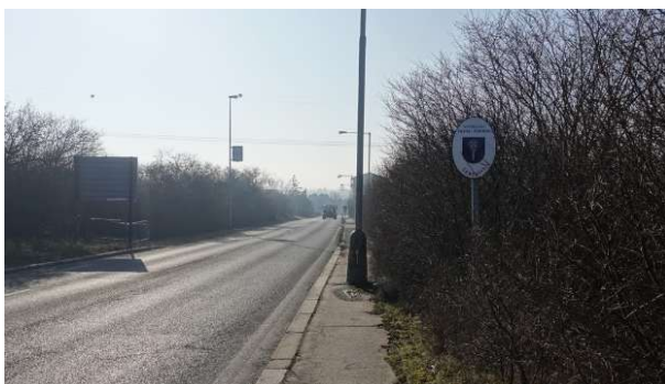
Obrázek 113 – Pohled na sloup VO v uprostřed chodníku pro pěší v MK K Hrnčířům.
