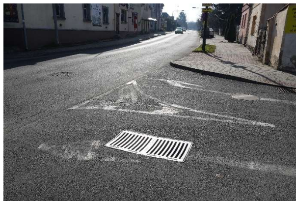
Obrázek 141 – Opatřebované VDZ V 9a a V 13 v MK K Labeškám.
