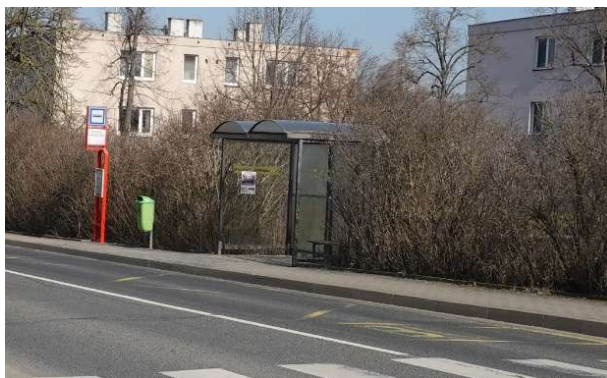
Obrázek 123 – Pohled na opotřebované VDZ V 11a v zastávce „Draždecká“.
