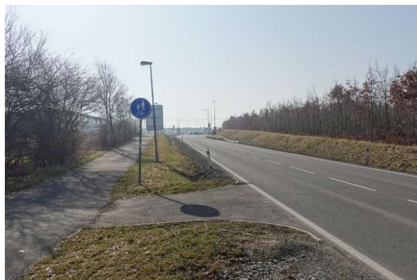
Obrázek 4 – Pohled na MK K Šeberovu ve směru k základní škole Šeberov.
