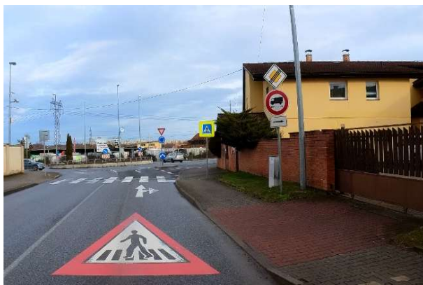
Obrázek 154 – Riziková kombinace SDZ P 3, B 17 a E 7b v MK K Šeberovu.
