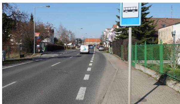
Obrázek 133 – Chybné oddělení zálivu od jízdního pruhu v zastávce „Pod Vší“ ve směru jih \Rightarrow sever.
