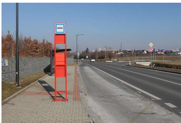
Obrázek 121 – Ukázka opotřebovaného VDZ V 11a v místě autobusové zastávky „Škola Šeberov“.
