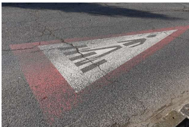
Obrázek 138 – Ukázka opotřebovaného VDZ V 15 se symbolem A 11 v MK K Labeškám.
