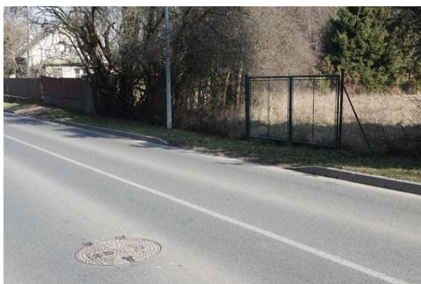
Obrázek 116 – Východní strana MK K Šeberovu, kde byla identifikována absence chodníku.
