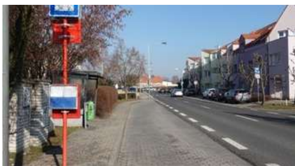
Obrázek 127 – Absence VDZ V 11a a v zastávce „Pod Vsí“.
