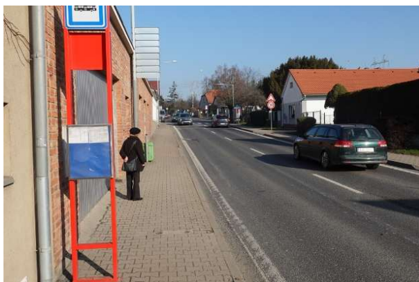
Obrázek 90 – Absence OOSPO prvků v místě zastávky „Šeberov“ v MK K Hrnčířům.
