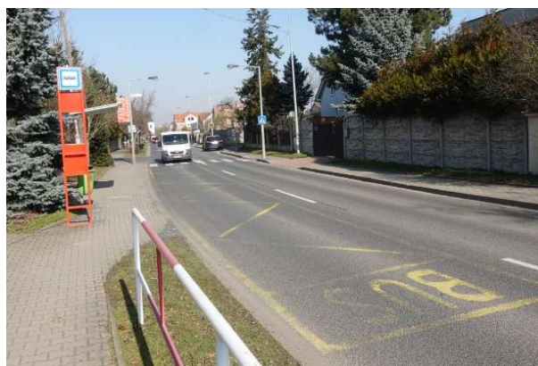
Obrázek 122 – Opotřebované VDZ V 11a v místě zastávky „Hrnčíře“.
