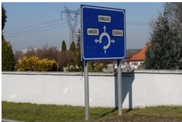
Obrázek 158 – Pohled na SDZ IS 9b na nedeformovatelné konstrukci v místě východního ramene MK K Labeškám.
