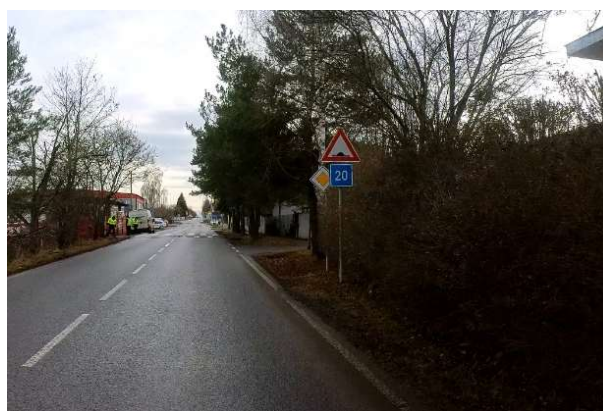
Obrázek 151 – Neadekvátní rozestup mezi SDZ P 2, A 7b a IP 5. v MK K Labeškám.
