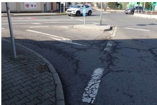
Obrázek 136 – Opotřebované VDZ V 2b v místě okružní křižovatky.
