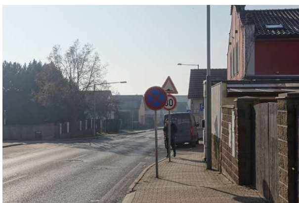
Obrázek 150 – Nedostatečný rozestup mezi SDZ B 26, A 7b a B 20a v MK K Hrnčířům.
