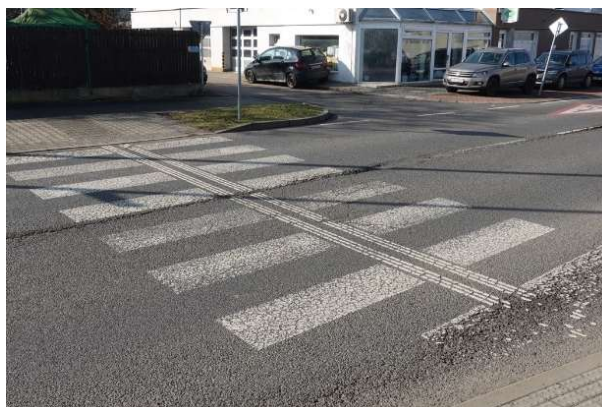
Obrázek 137 – Pohled na opotřebované VDZ V 7a a V 2a v MK K Labeškám.
