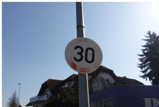
Obrázek 145 – Pohled na vybledlé SDZ B 20a v MK K Labeškám.
