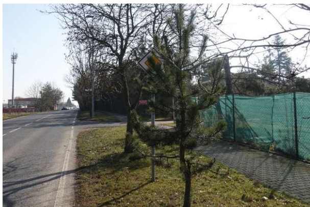
Obrázek 142 – SDZ P 2 zakryté zelení v MK K Labeškám.
