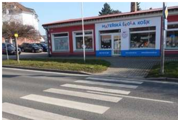
Obrázek 85 – Absence varovného a signálního pásu u přechodu pro chodce v těsné blízkosti mateřské školy Košík.
