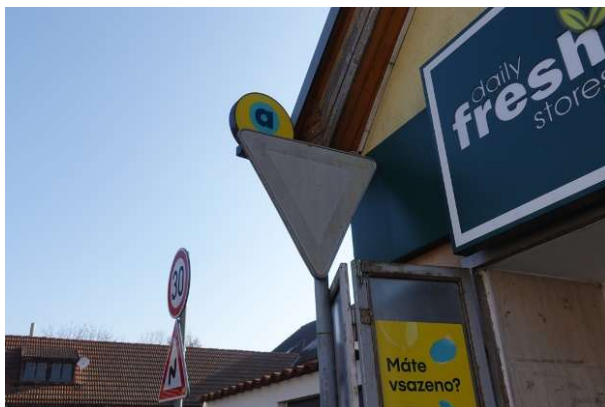
Obrázek 144 – Vybledlé SDZ P 4 v místě stykové křižovatky MK V Ladech a K Hrnčířům.
