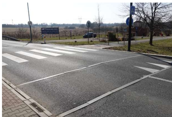
Obrázek 8 – Pohled na zpomalovací práh v blízkosti stykové křižovatky MK K Hrnčířům x Nad Jordánkem.
