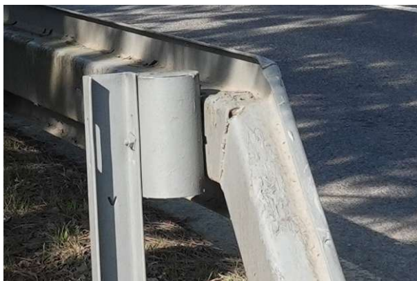
Obrázek 156 – Ukázka neadekvátního propojení pásnice svodidla a výškového náběhu.
