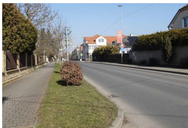
Obrázek 163 – Ukázka absence VDZ V 1a a V 4.
