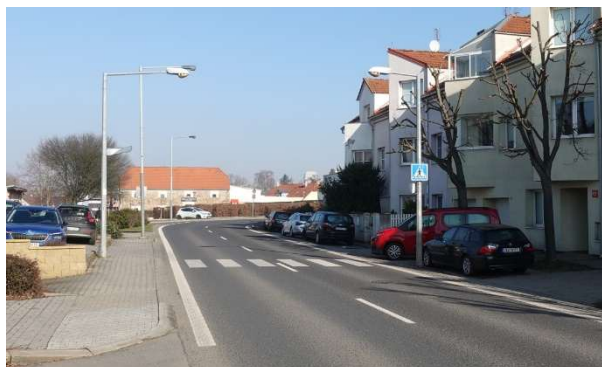
Obrázek 99 – Pohled na zaparkovaná vozidla v blízkosti přechodu pro chodce v MK K Hrnčířům.
