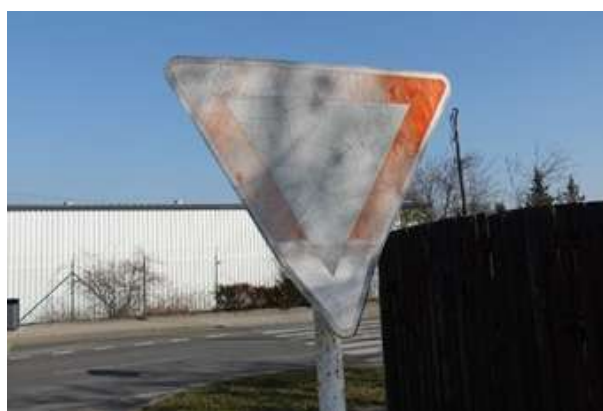
Obrázek 147 – Neadekvátní stav SDZ P 4 v místě stykové křižovatky MK Sladovnická a K Labeškám.
