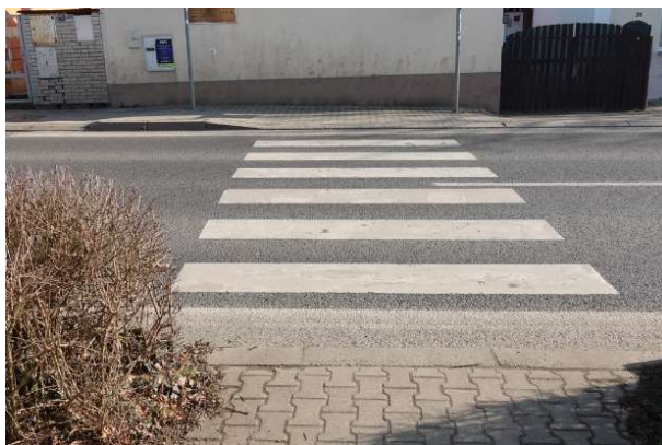
Obrázek 84 – Absence prvků pro OOSPO, konkrétně varovného a signálního pásu, v místě přechodu pro chodce v MK K Hrnčírům.
