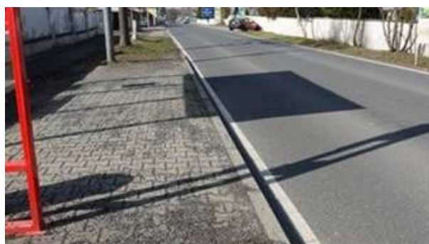
Obrázek 128 – Absence VDZ V 11a a v zastávce „Hrnčířský hřbitov“.
