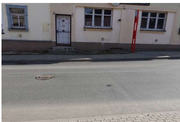
Obrázek 162 – Absence VDZ V 1a a VDZ V 4 v těsné blízkosti autobusové zastávky „Hrnčíře“.
