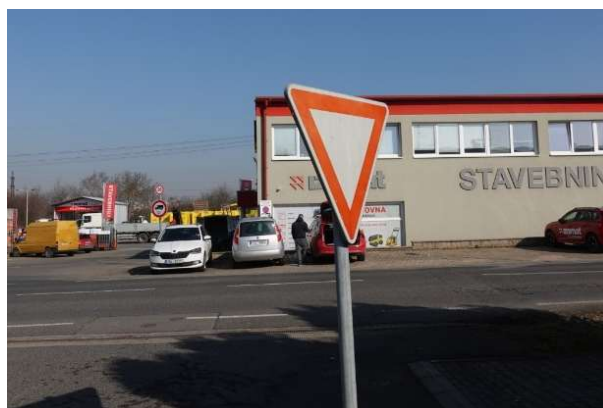
Obrázek 149 – Ukázka pootočeného SDZ P 4 v křižovatce MK Za Rybníčky a K Labeškám.
