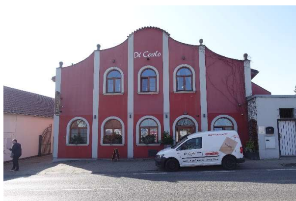
Obrázek 80 – Snížená obruba a odstavování vozidel před restaurací.
