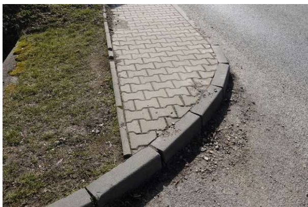
Obrázek 88 – Absence varovného pásu a snížené obruby v místě stykové křižovatky ulic K Šeberovu a Zadní.
