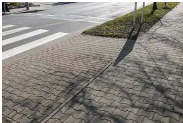
Obrázek 87 – Ukázka chybně realizovaného signálního pásu v blízkosti stykové křižovatky ulic K Šeberovu a Za Jednotou.
