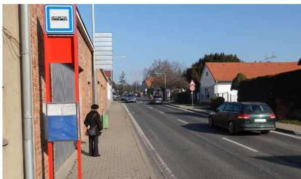
Obrázek 125 – Absence VDZ V 11a v místě autobusové zastávky „Šeberov“.
